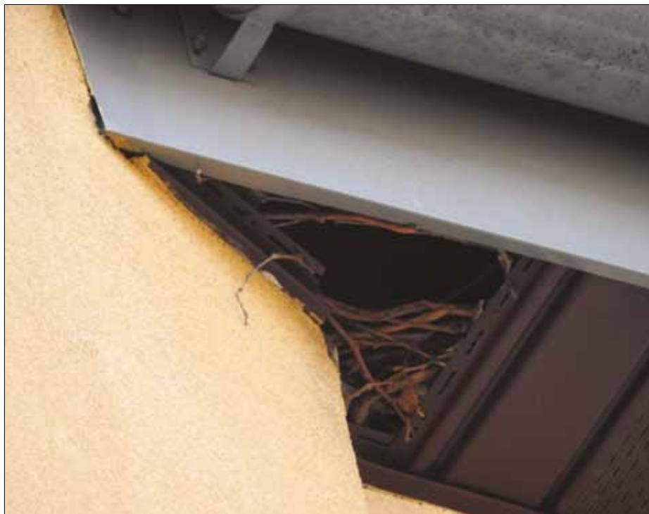
Fot. 110. Odpadła podbitka pod dachem bloku odsoniła lukę, którą kawki, cierpiące na deficyt miejsc lęgowych błyskawicznie wykorzystały do budowy gniazda. Fot. P. Mirski
