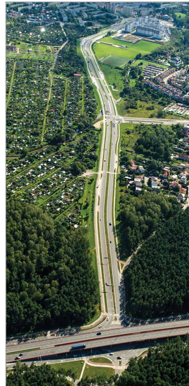
Zmodernizowana i wydłużona ul. Świętokrzyska
