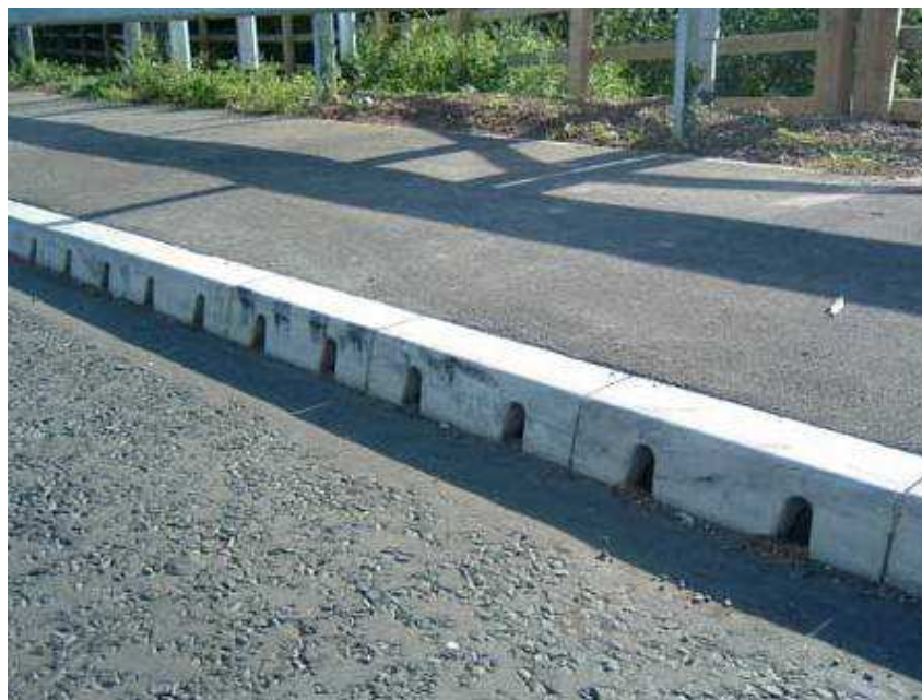
Rysunek 9 Krawężnik odwadniający - przykład zastosowania
