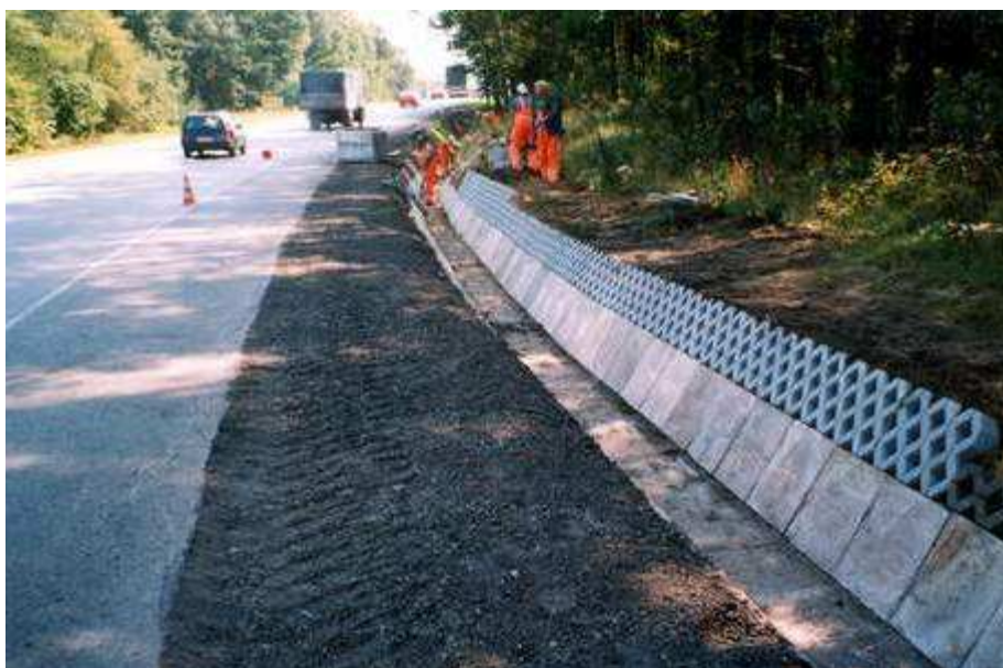
Rysunek 7 Przykład odwodnienia drogi przy pomocy warstwy chłonnej i płytkiego rowu (źródło: www.zbd.at.com.pl )
