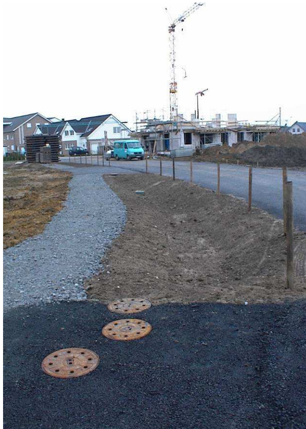
Rysunek 25 Przykład zbudowanej rigoli podłużnej zasilanej powierzchnio i podziemnie
