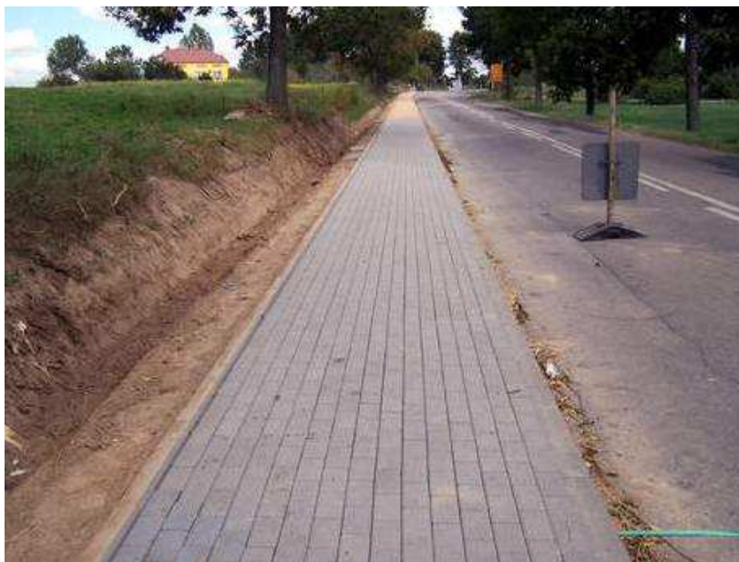
Rysunek 6 Rów przydrożny bez umocnionych skarp (źródło: www.zbd.at.com.pl )
