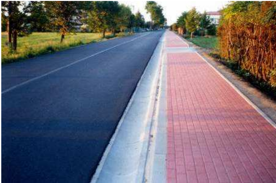
Rysunek 4 Przykład rynny muldowej wykonana z prefabrykatów (źródło: www.zbdat.com.pl )
