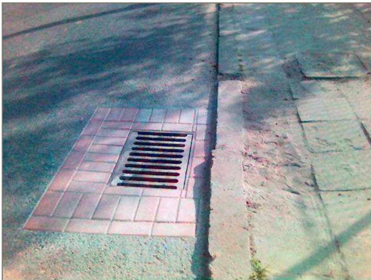
Rysunek 12 Wyregulowany wpust uliczny przy pomocy kostki betonowej
