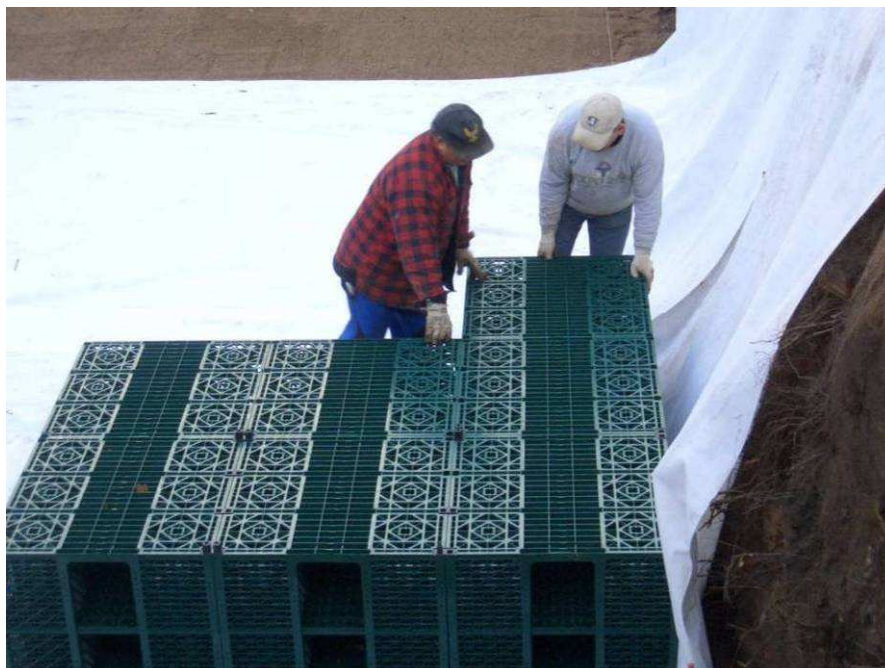
Rysunek 18 Przykład zabudowy skrzynek rozsączających w gruncie (źródło: www.polyteam.pl )
