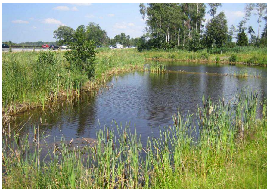
Rysunek 42 Przykład stawu sedymentacyjnego odwadniającego drogę ekspresową (źródło: Dorota Gatkowska-Jeleńska1 Józef Jeleński2 – Naturalna estetyka zbiorników retencyjnych deszczówki)
