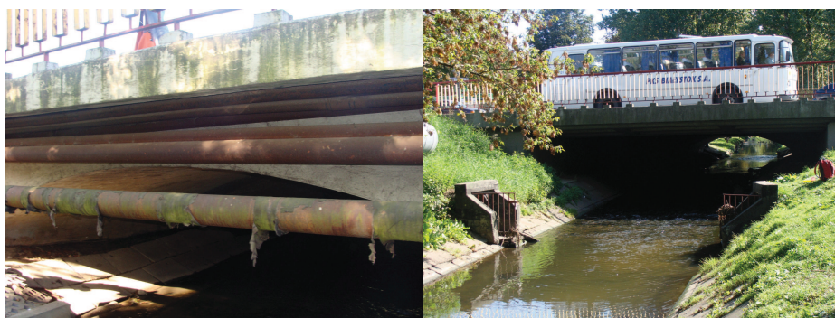
Fot. 4.1 (po lewej) Widok mostu w ul. Sienkiewicza od strony wody górnej
