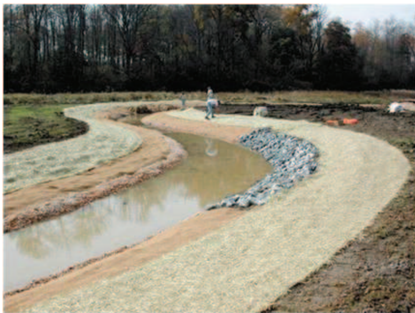
Rysunek 8.20 Przykład remeandryzacji prostoliniowego odcinka niewielkiej rzeki podczas prac wykonawczych.
