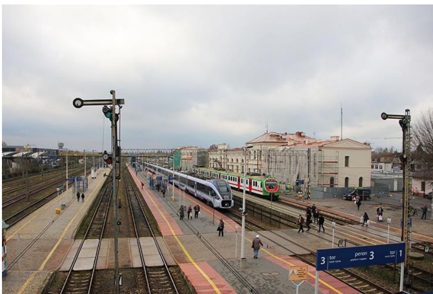
Fotografia 3. Widok na dworzec kolejowy w Białymstoku.
