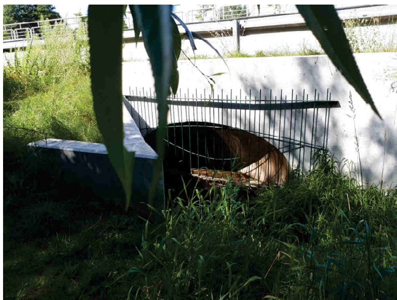
Fot. 54 Przepust dopływu Dolistówki pod Trasą Generalską
