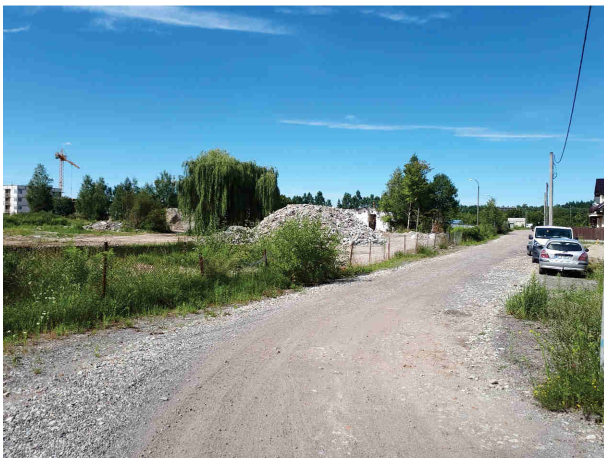
Fot. 54 Rozbiórki i teren w trakcie przygotowań do zabudowy, ul. Warzywna
